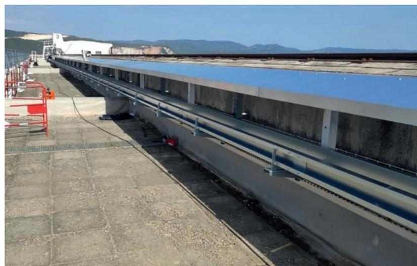
tena portacavi deve guidare e proteggere i cavi elettrici, di comunicazione e sensori collegati alla valvola. „La valvola deve prevenire il sovraccarico delle turbine. In casi di
