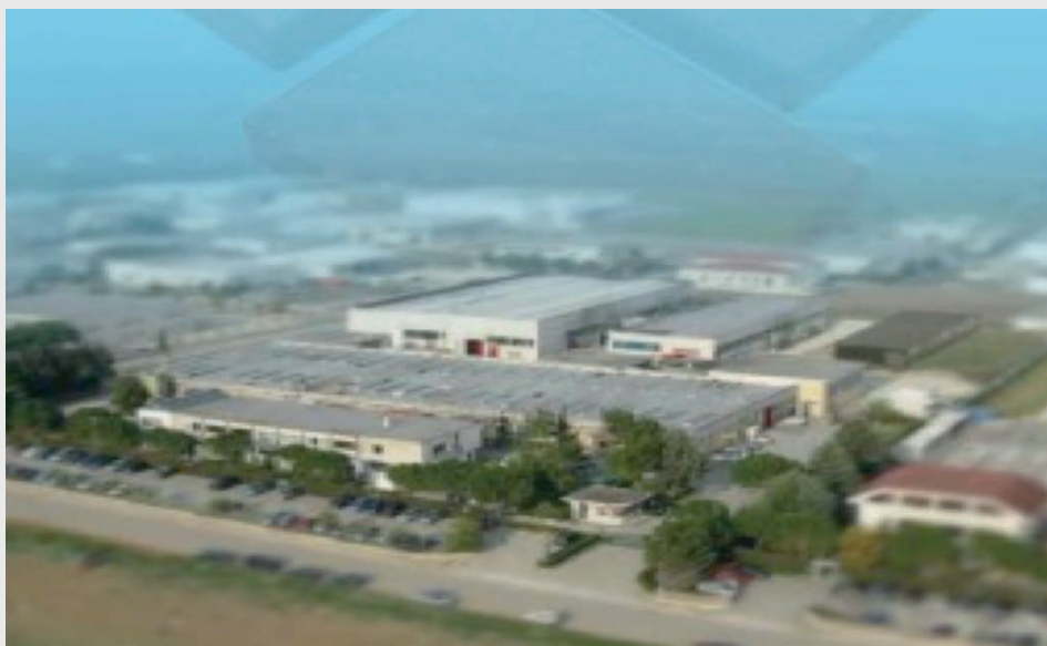
Eurocarbo S.p.a. , via S. Scolastica 35, 64013 Corropoli
