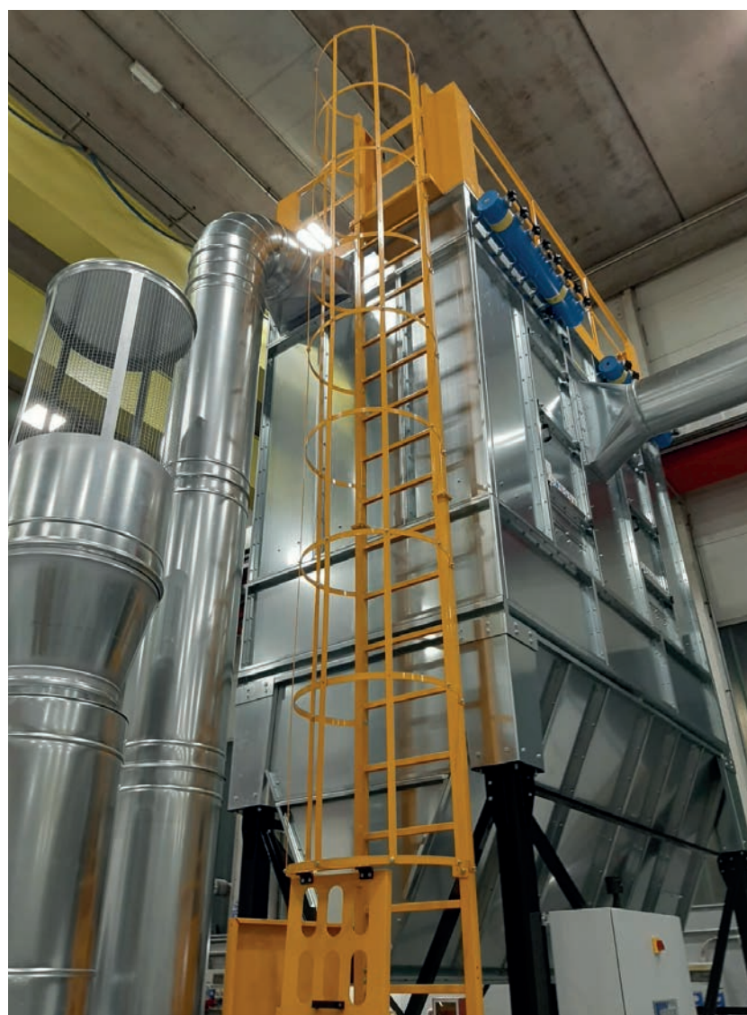
Per l'aspirazione piano cabina, l'impianto è composto da tubazioni flessibili, un terminale utilizzabile anche durante le operazioni di pulizia manuale della camera e un collettore di aspirazione indipendente
