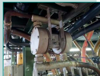
Una delle prime pompe AODD installata negli anni 80, e continua a funzionare
